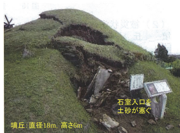
図-2 熊本地震で被災した釜尾古墳の様子 5)
