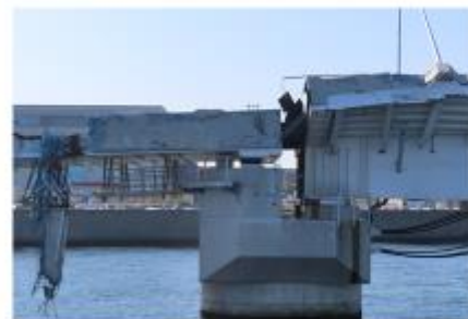
PC栈橋と箱桁橋の接合部分②
