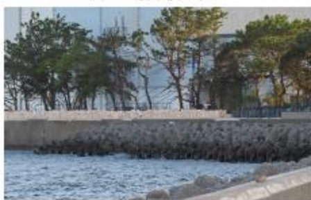
幸浦の護岸復旧状況①
