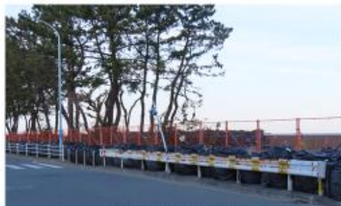
福浦の護岸復旧状況
