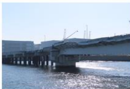
PC栈橋と箱桁橋の接合部分①
