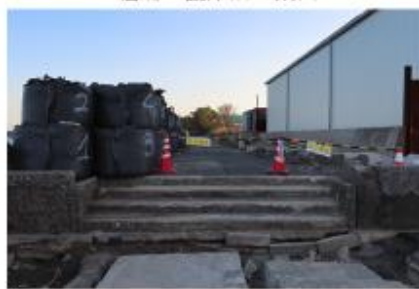
幸浦の護岸復旧状況②
