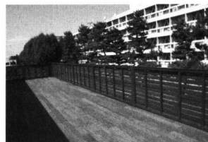
二階ウッドデッキ
