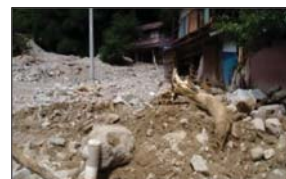
土砂災害により人家2戸半壊(南砺市)
