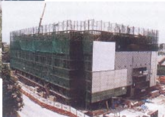
▼ 着々と建築が進む新実験棟、 6/15現在
