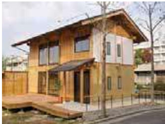
写真 2 実験住宅「律周舎」
