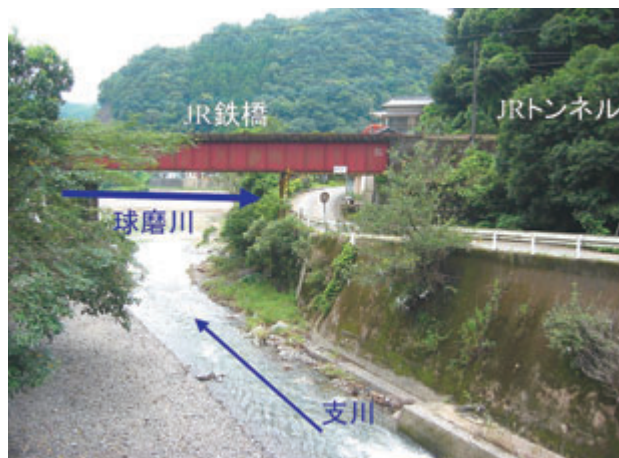
写真3 深水地区（JR鉄橋をくぐる道路の部分から越水し、隣接する家屋の1階部分が浸水した）
