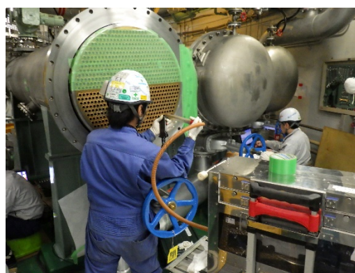
図.2 渦流探傷検査作業風景
