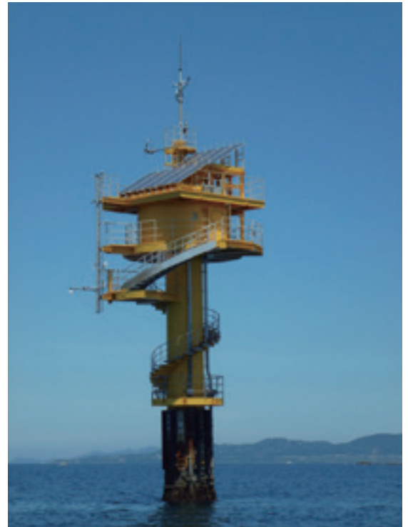
図1 白浜海象観測所、田辺中島高潮観測塔（塔体の太くなっている部分が計測室、海面上12.5m）
