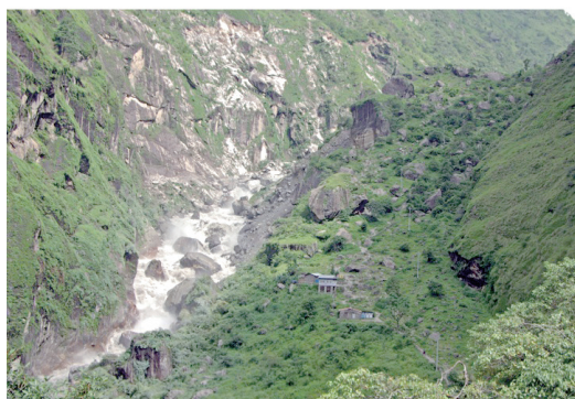
写真1 タルの土砂ダムを下流から見る（図1②）。巨岩に注目。途中にある茶屋の建物と比べるとその大きさが実感できる。右岸の岸壁には崩壊土砂の痕跡がまだ残っている（2009年7月31日撮影）。
