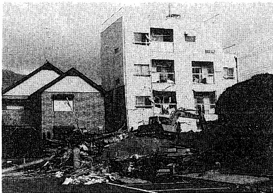
写真10 B-2邸および隣接した鉄骨建物
