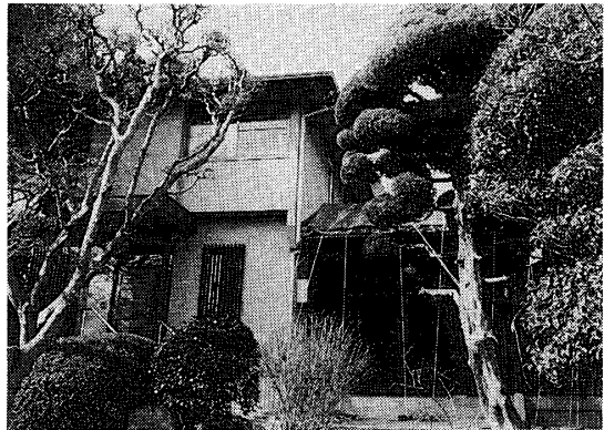
写真5 A邸内のツーバイフォー住宅と木造門扉
