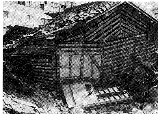
写真28 F 邸周辺地域の木造住宅の倒壊
