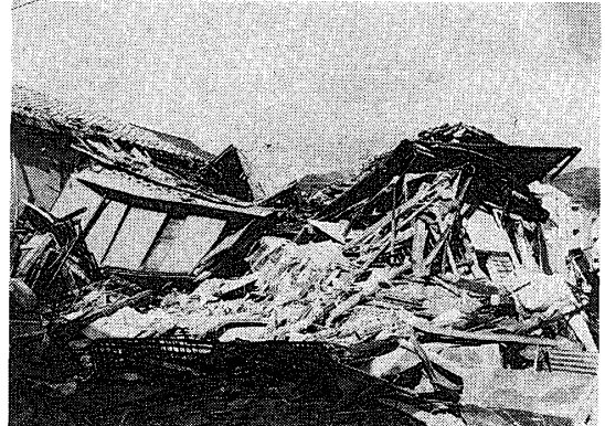
写真7 B-1邸左側に隣接した木造住宅の倒壊
