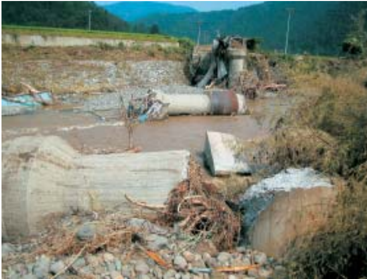
写真1 JR第5足羽川橋梁の被害状況（手前の橋脚が折れている）
