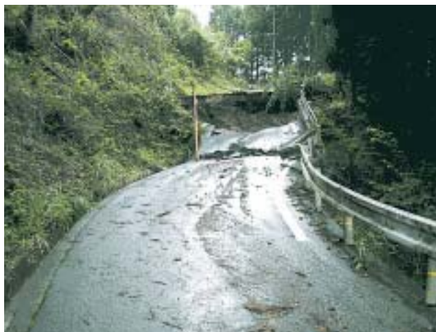
写真2 大規模な崩壊が発生した木沢村阿津江地区。崩壊地の上部には多数の亀裂が見つかり、それら亀裂を結んだ線上に位置する林道に2m近い段差が現れた。崩壊地上部に残った不安定土塊は、少しずつ移動していると思われる。
