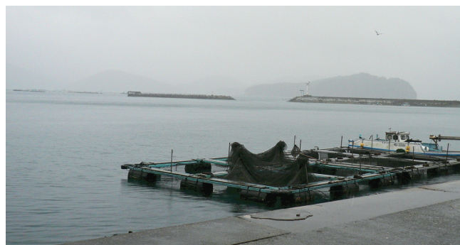
写真 2 魚類養殖筏区画が全滅した礫浦漁港。写真奥右側の防波堤開口部外にあった区画が被災した
