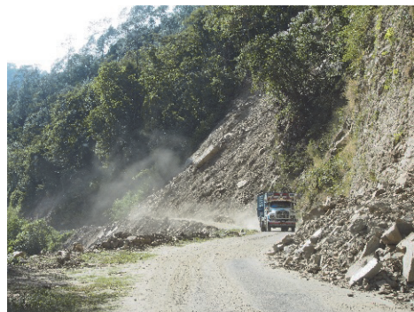
写真4 一部崖が崩れている道（ロイヤル・マナス国立公園に向かう道中にて）
