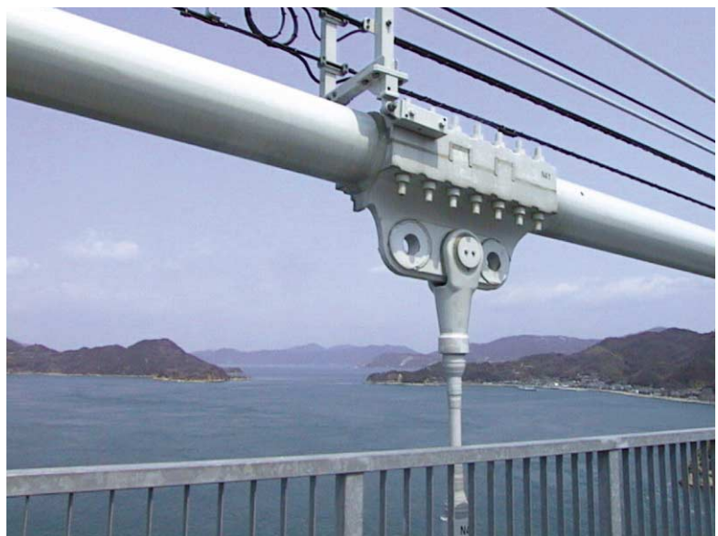
写真1 西瀬戸自動車道(しまなみ海道)の最も四国よりの橋である来島海峡大橋の大島側の吊り橋のセンタースティが破断 (撮影・本田利器)
