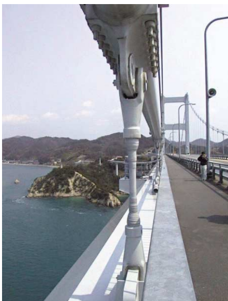
写真1 西瀬戸自動車道(しまなみ海道)の最も四国よりの橋である来島海峡大橋の大島側の吊り橋のセンタースティが破断 (撮影・本田利器)
