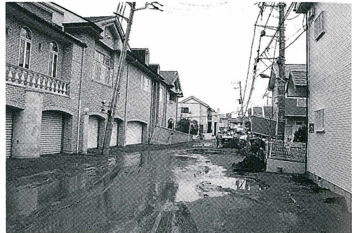
写真6 噴砂で覆われた道路（浦安市今川）
