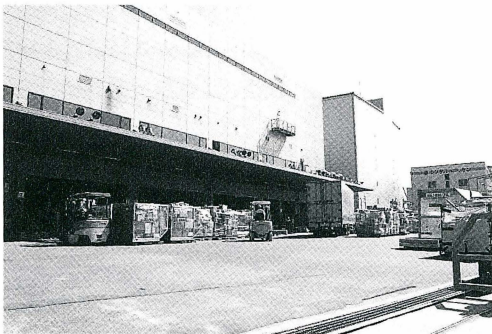
写真4 液状化被害が軽微な事業所（新木場）
