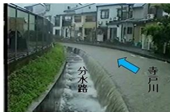
Fig.5b トンネルに流れ込んでいる様子 (H21 向日市呑龍トンネル公共事業評価調書)
