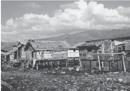
写真1 ウリンにおける津波被害（筆者撮影）
