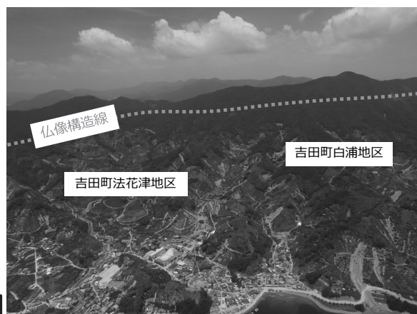
写真 1 発生直後の斜め空中写真 (航空機から撮影 (千木良雅弘氏提供))
