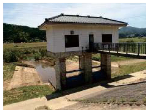
図-3 蓼原川樋門
