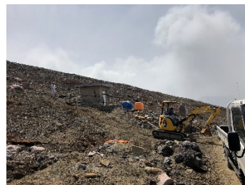
図5 修理途中の観測室
