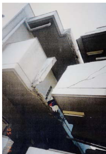
写真7 エキスパンションの左ずれ変位
