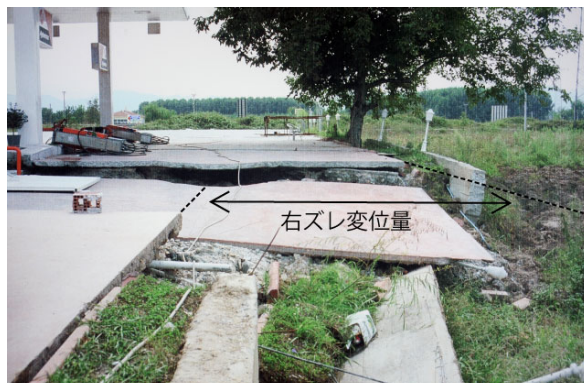
写真 2 双子のガソリンスタンドの右ずれ変位量
