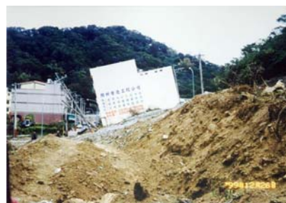
写真 5 逆断層上のRC建造物
