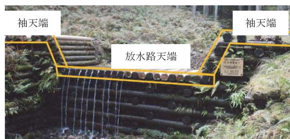
写真7 木製治山ダム
