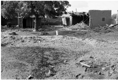
写真 1 ニアメ市における大雨による家屋の 倒壊 (2012 年)
