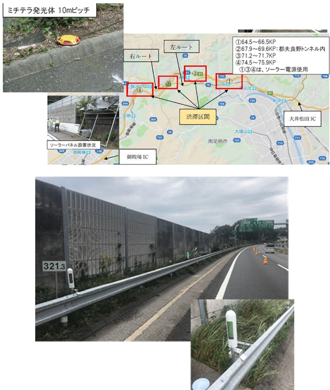
図 7-1 走光型視線誘導灯の採用事例
