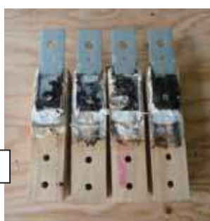
写真 2 腐朽処理後の例
