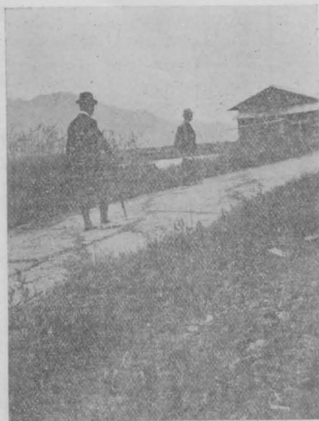
桃島道路及水田龜裂
