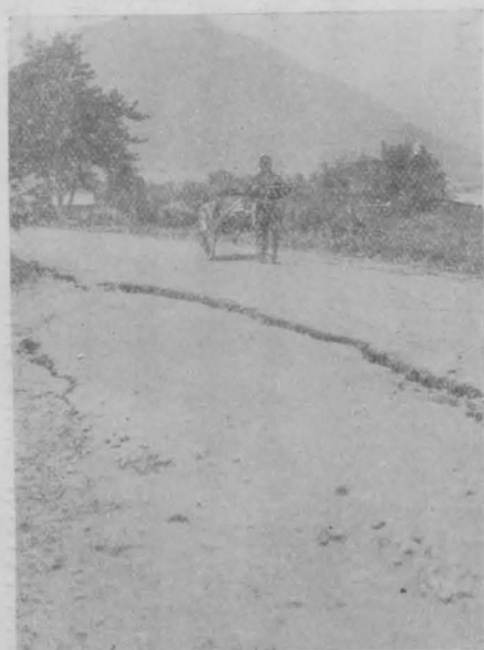
出石町の北縣道上の龜裂
