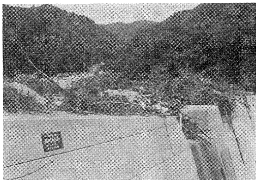
第 10 図 橘川堰堤 (1974 年災後建設)
