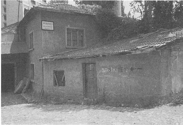
図3 エスキシェヒル市内の製粉水車場
