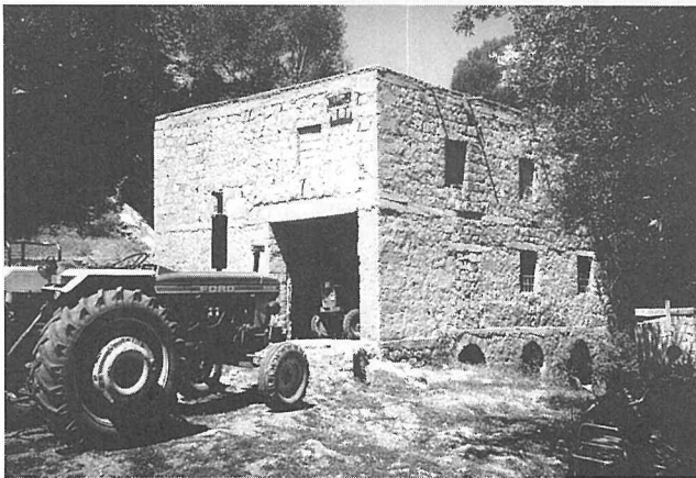
図4 ビュンヤン町有水車場 (建物の左後方に斜めに掛けられた導水管も見える)
