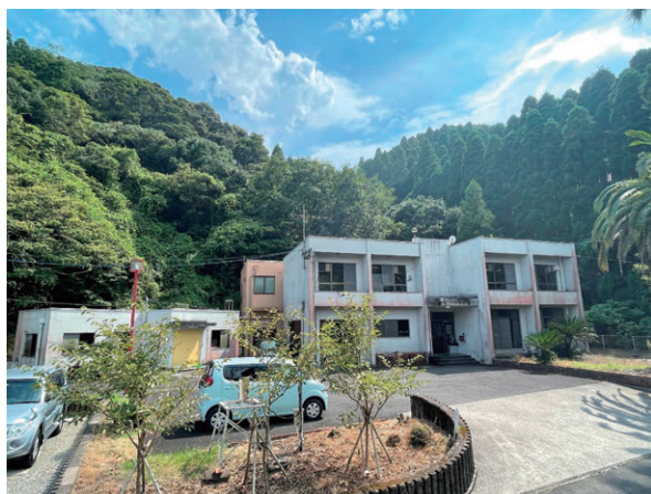
観測所外観。左下の黄色の扉は観測坑道の入り口
