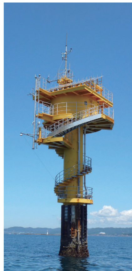
田辺中島高潮観測塔
