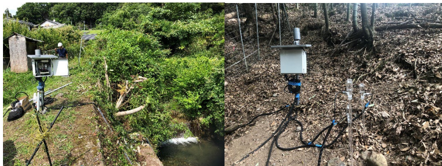
写真1．池ノ尾川での雨量・水位観測 写真2．志津川地内における観測点
