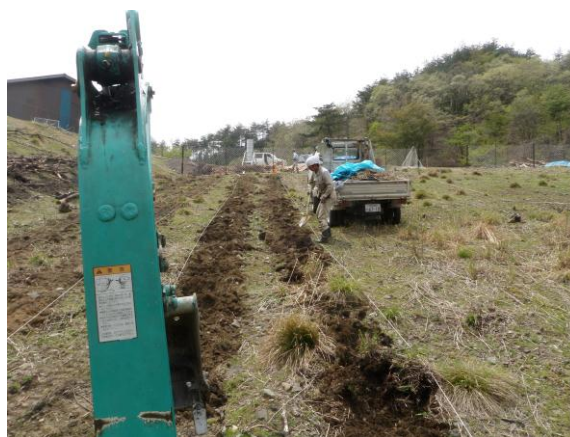
写真 4 林道残土の斜面にカヤを移植 （写真撮影：今北哲也、2009 年）
