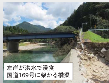
岩盤基礎まで洗掘された橋脚は流失
