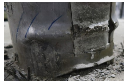
図-13 実験終了時における UBCH における鋼管および鋼管内部のコンクリートの損傷状況(鋼管を一部除去)
