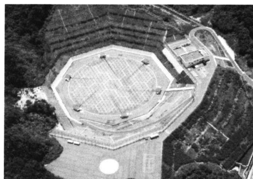
図1: MUレーダー。中央の円形の部分が475本の八木アンテナから構成されるフェーズド・アレイ・アンテナ(直径103m)。
