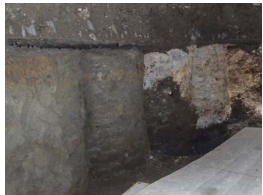
写真1 柱状改良体と二水石膏（奥）
