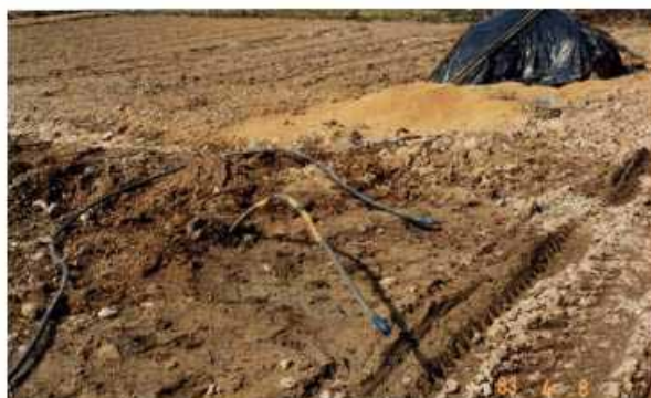
写真 12 左は切断したケーブルを掘り出したところ。右は手作業で埋設作業
