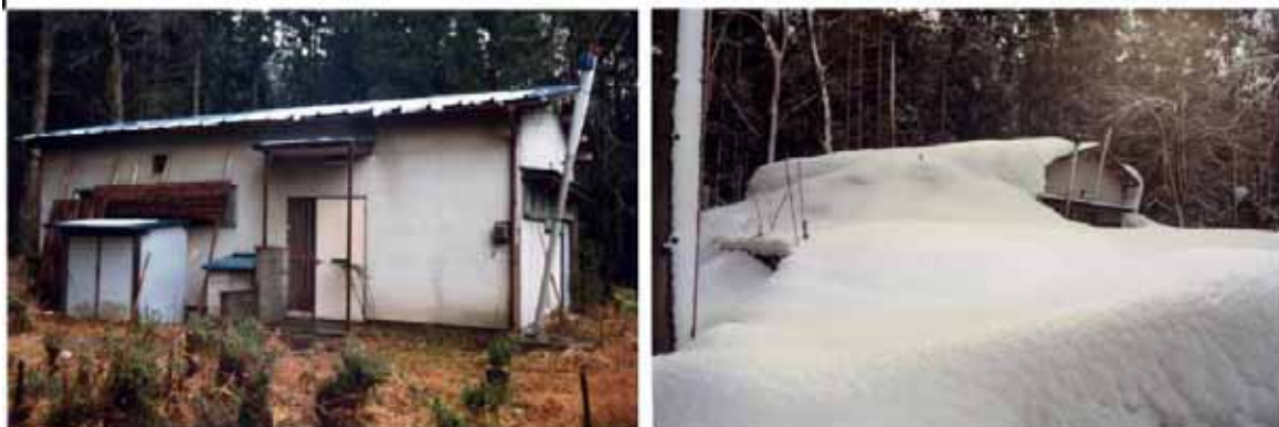
写真 17 窓を板で塞ぐ雪囲と豪雪で埋まった宿舎
