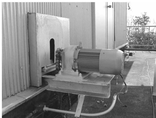
新設モーター取付
