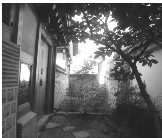
写真4-2 道から見たK邸の屋敷出入口の様子
