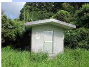
口永良部島 観測室
