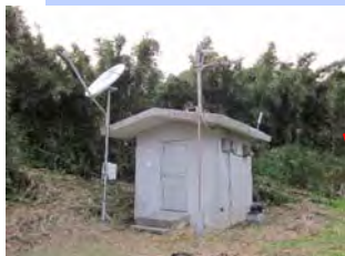
諏訪之瀬島 観測室
