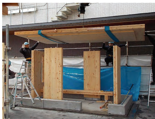
図 3：CLT を用いたバス停
