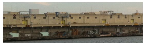
写真-6 公共上屋（安治川9号上屋）の外装色（筆者撮影）
