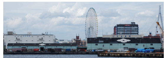
写真-5 築港地区に現存する昭和初期に竣工した倉庫(筆者撮影)
