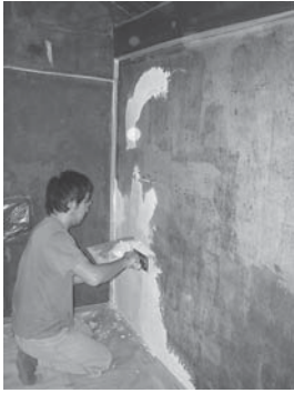
写真2 壁の塗り替え作業
