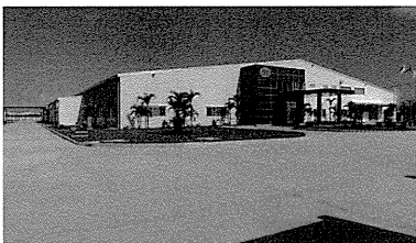
図5 M工場外観
