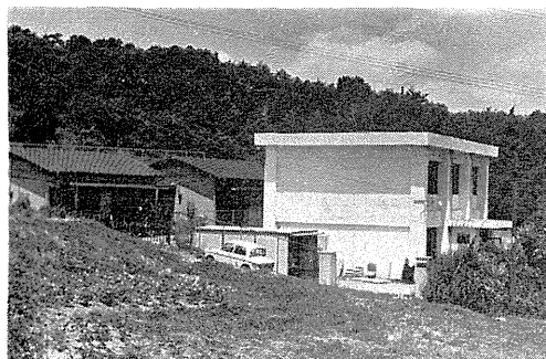
写真一2.25 屯鶴峯地殻変動観測所本館および職員宿舎
