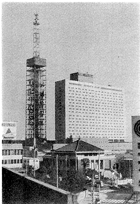
写真—3.12 風圧測定を行なっている高層建物
