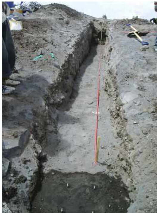
写真4 水管傾斜計設置用の穴
