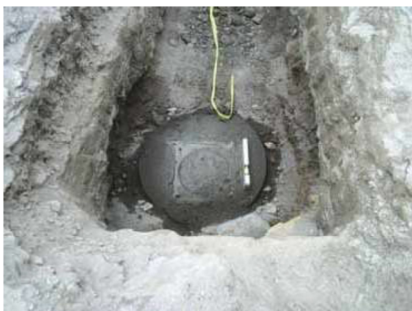
写真3 水管傾斜計センサ部の台
