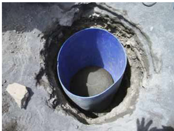
写真5 地震計台と保護管
