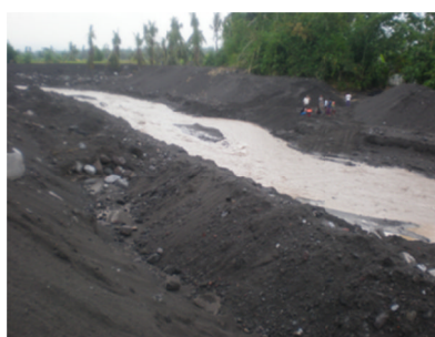
Photo 9(d) Collapse type 4
