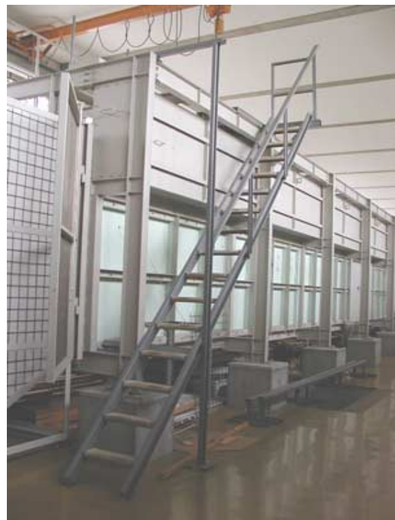
写真8 完成した階段
