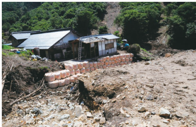
写真3 谷の出口正面にあった被災した家屋。写真右手前にあった家屋が土石流により破壊され住民1名が死亡した。左手の家屋は一部のみ損壊。
