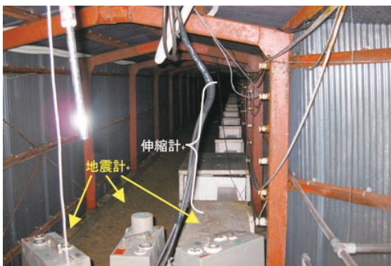
図2 蔵柱観測坑道内部
