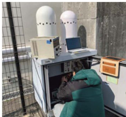
屋外モニタリングポスト修理
